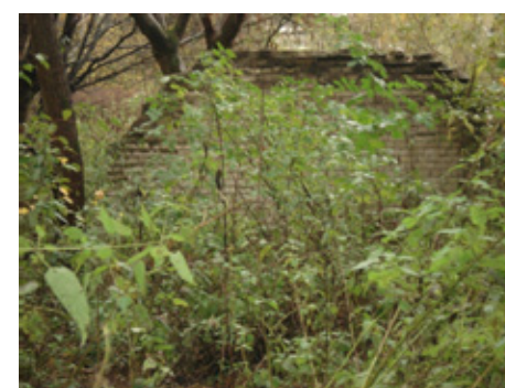
Die Mauern des alten Pförtnerhauses
